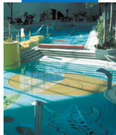
Példa mozaik és klinker burkolólapok ragasztására úszómedencében
