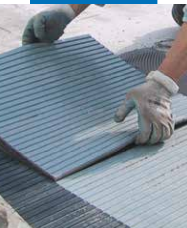
Cementes felület burkolása gumi burkolattal Granirapid-dal
