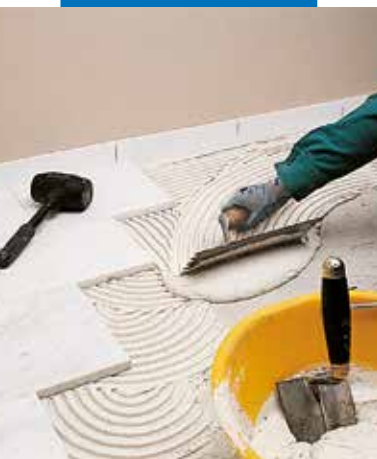
Fehér carrarai márvány ragasztása fehér Granirapid-dal
