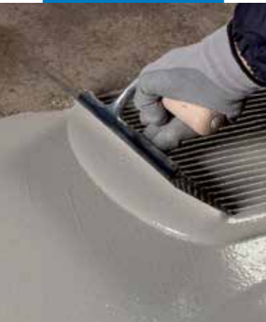
A Mapelastic Turbo első rétegének felhordása
