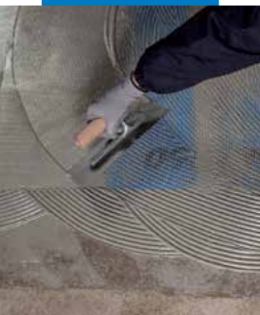
Mapenet 150 elhelyezése a Mapelastic Turbo első rétegébe amíg az még nedves
