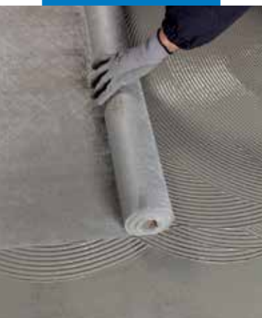
Mapetex Sel elhelyezése a Mapelastic Turbo első rétegébe amíg az még nedves
