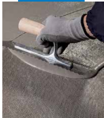
A második réteg Mapelastik Turbo felhordása az első, Mapetex Sel-lel erősített rétegre
