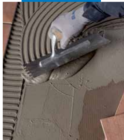
Burkolat ragasztása Elastorapiddal
