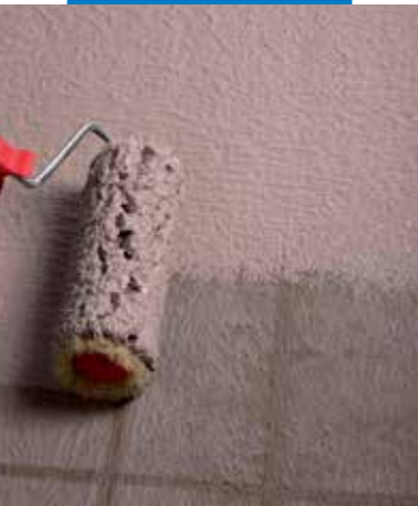
Terasz vízszigetelésének felhordása hengerrel
